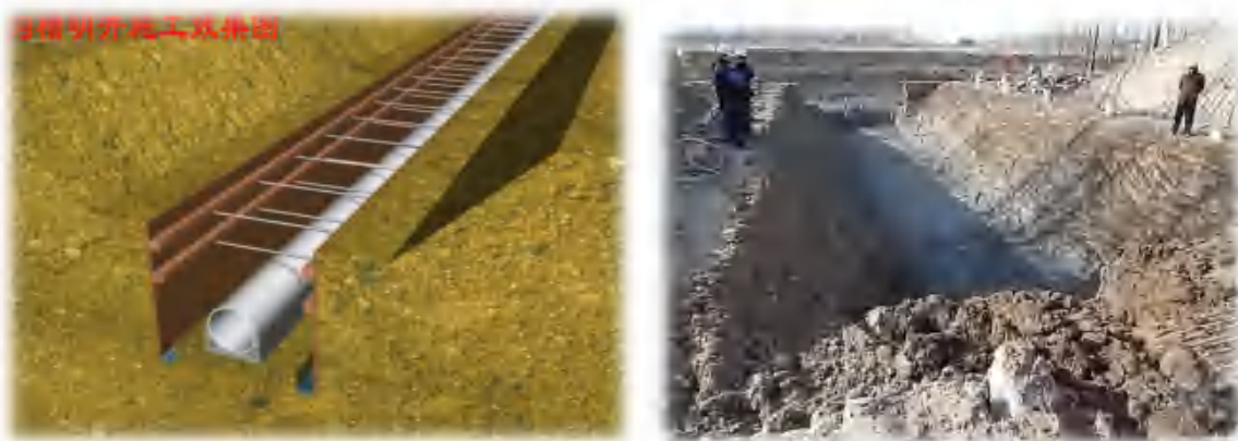
管道沟槽开挖
