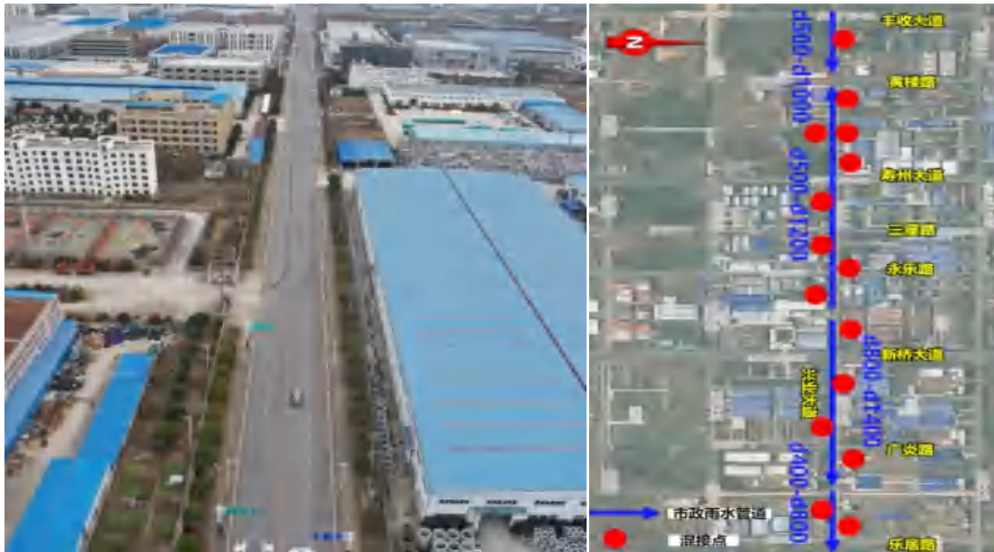
兴业大道现状道路
