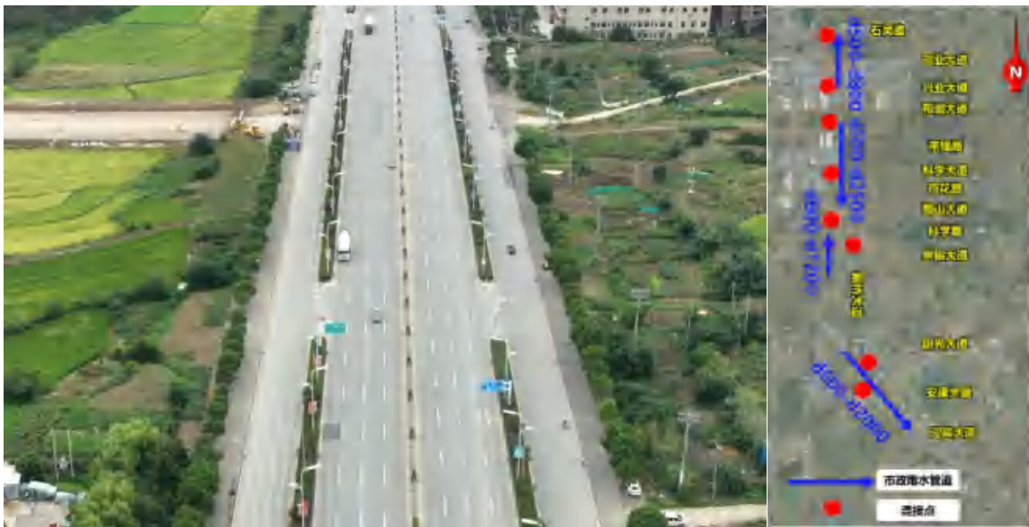
新桥大道现状道路
